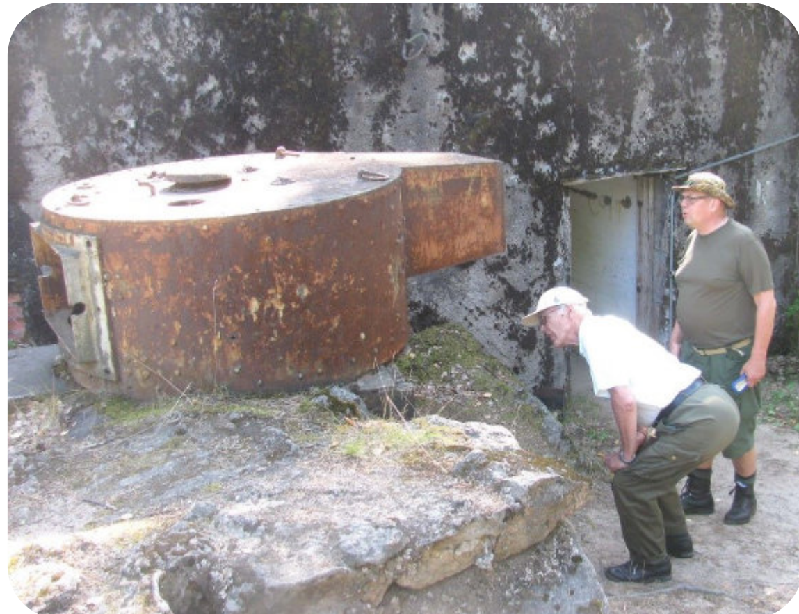
Venäläisen panssarivaunun BT-T torni, mihin oli asennettu konekivääri, korsun sisäkäynnin varmistukseksi.
