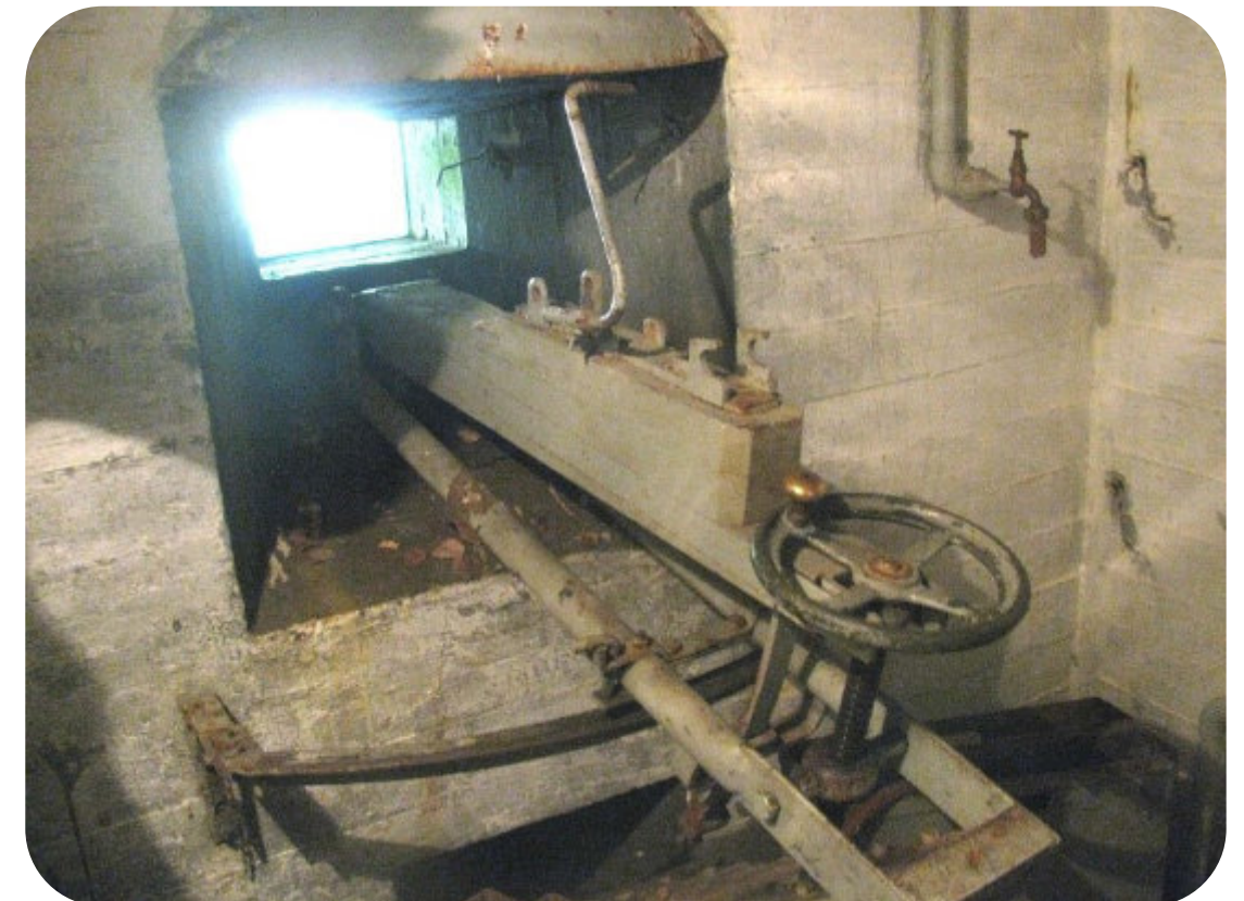
Korsun sisällä oleva konekiväärin asema (huom. oikealla oleva vesihana jäädytysvettä varten)
